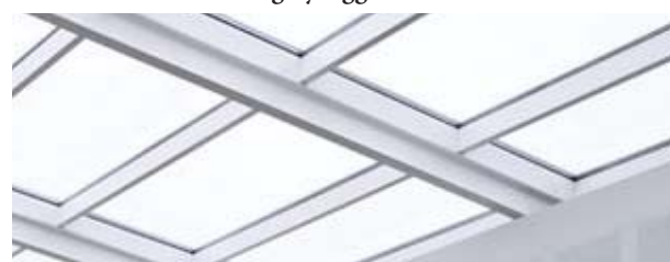
Belysning med ovenlyseffekt i tunnel
