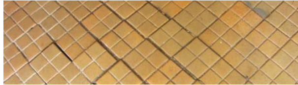
Gulvklinter afrenses og repareres
