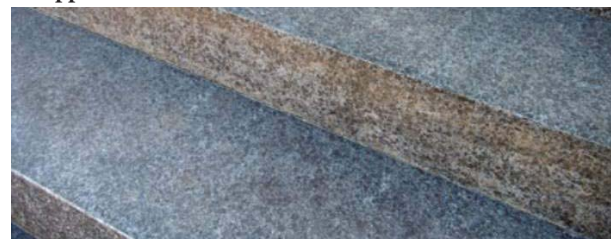
Ny trappe i granit
