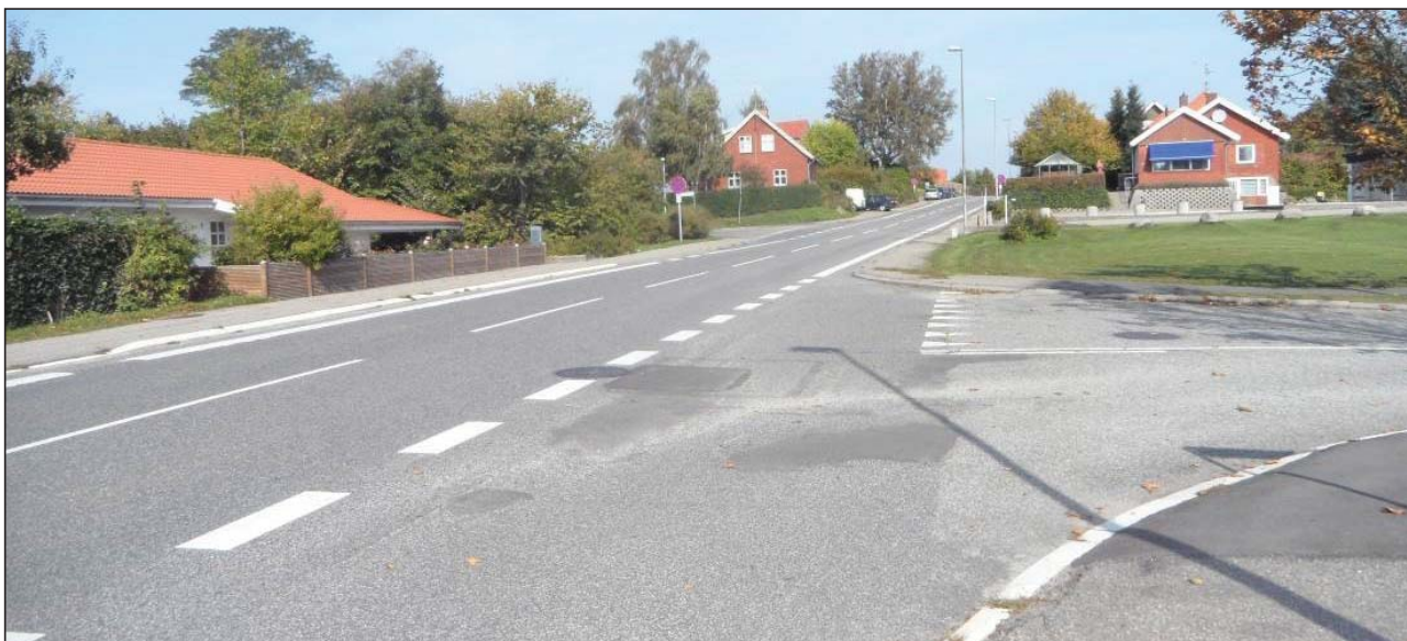
Langkæret ud mod Hillerødvej - set mod Lynge Bytorv
